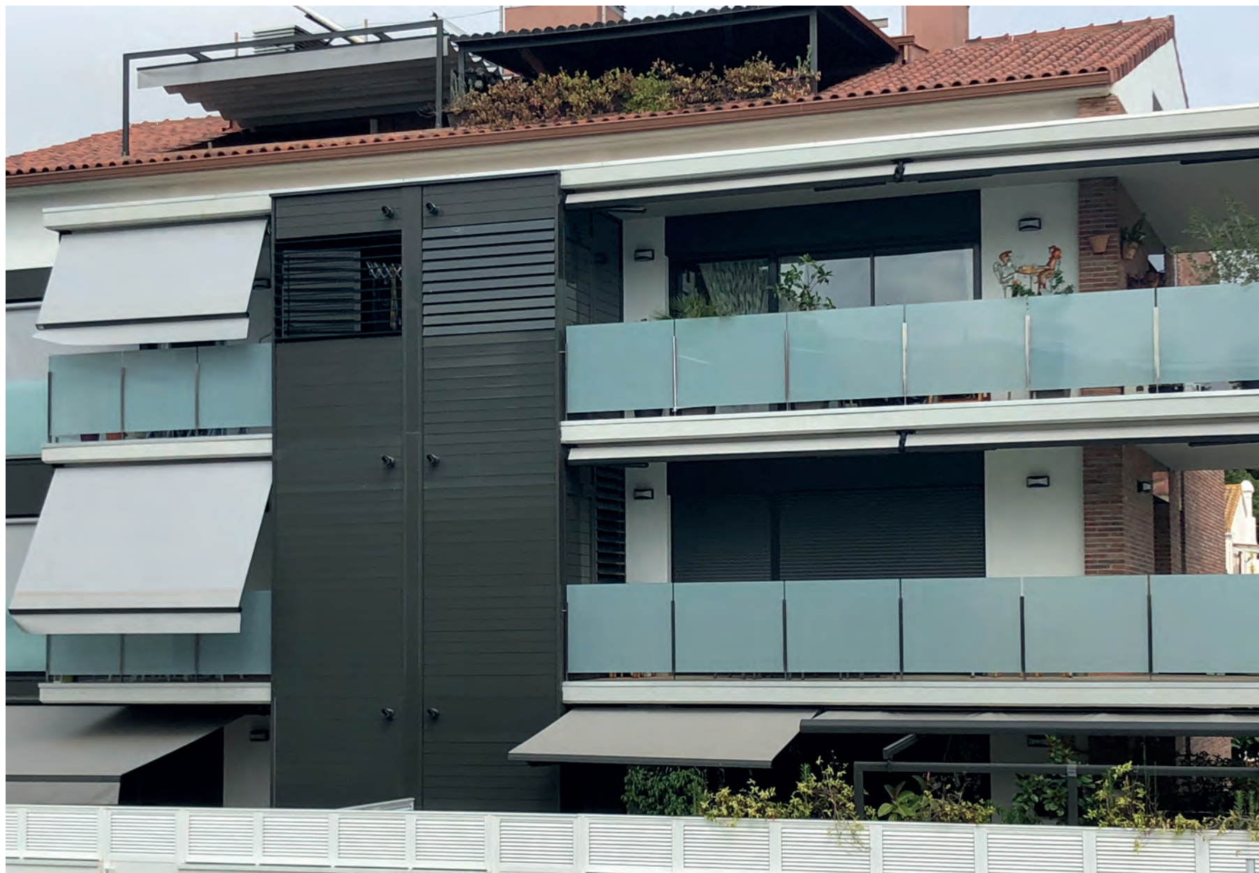
Exterior bloque VETRO-OPACO
