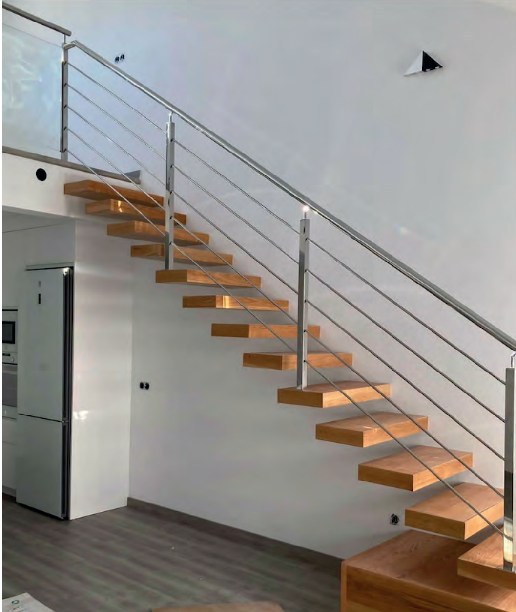
Escalera interior FLOTANTE
